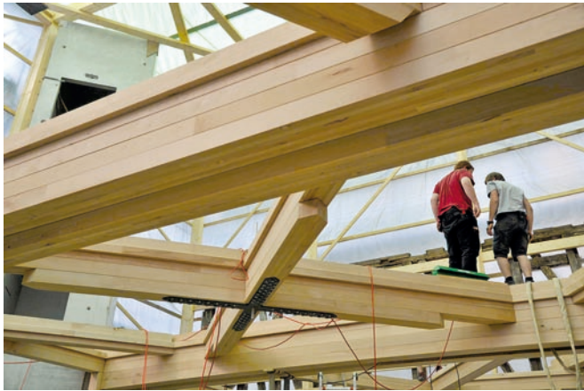
5 | Das „Herzstück“ der Deckenkonstruktion über dem Erdgeschoss bei der Montage von unten gesehen
