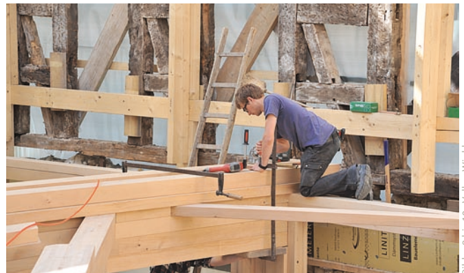
9 | Hier wird Lage 6 mit der Schraubzwinge auf die Lage 5 gezogen. Nun kann das Einschrauben beginnen.
