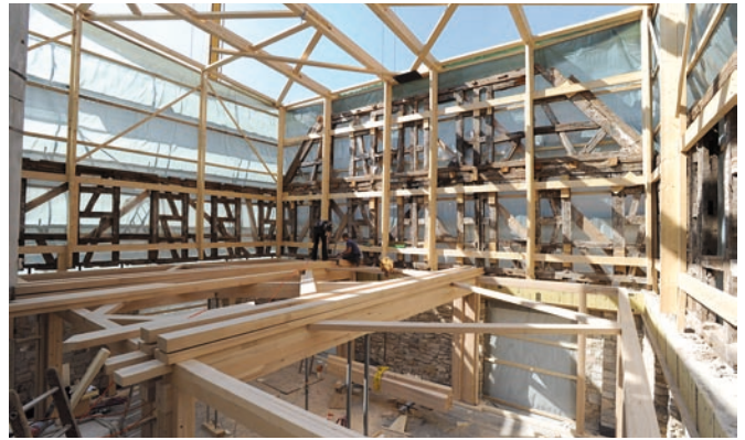
8 | Hier ist die letzte Lage (Lage 6 aus Bild 3) aufgelegt und auf einer Seite fixiert. Die Überhöhung zeigt sich am „Aufschnabeln“ (Fuge) der Hölzer.
