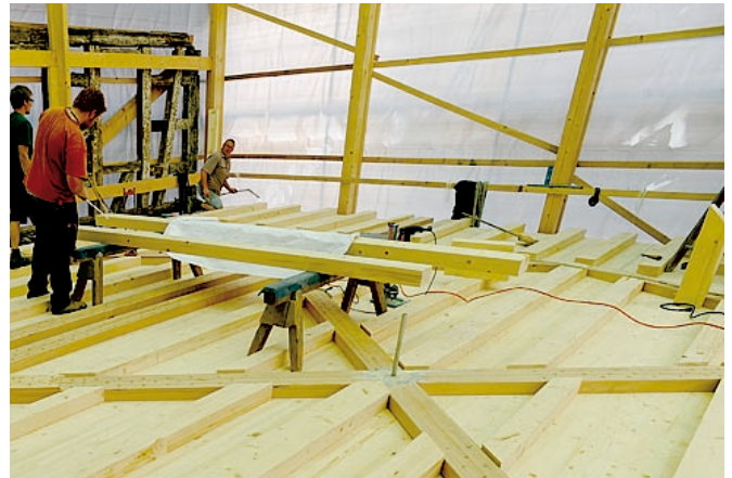
6 | Hier sind bereits die Mehrschichtplatten und die 12 cm hohen KVH-Hölzer eingebaut
