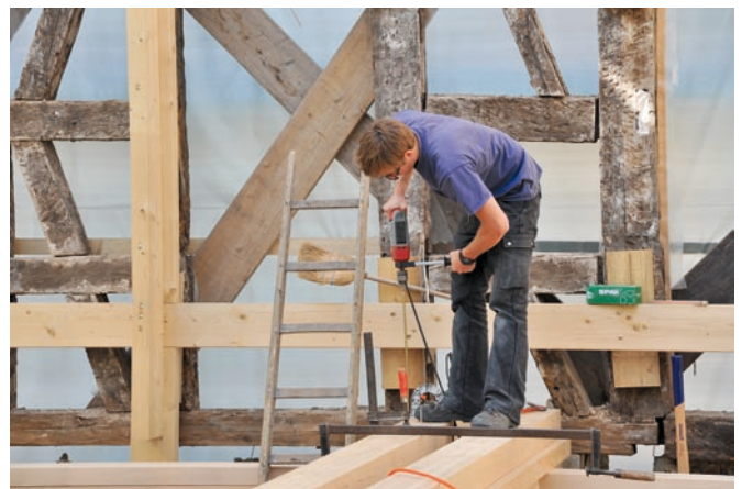
10 | Das Einschrauben der SPAX-S® Schrauben 12,0 × 600 erfolgte mit Maschinen der Fa. Kress (1055 HTC, 1050 W, Drehmoment bis zu 110 Nm).
