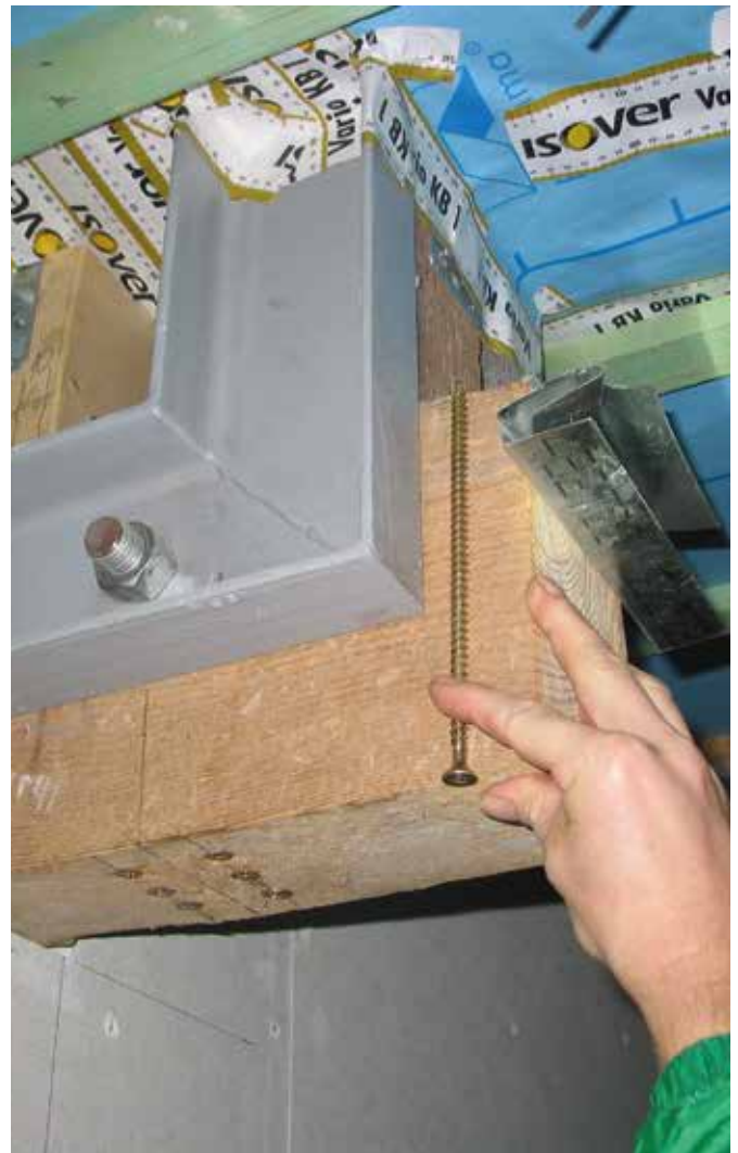
Nachträgliche Querzugverstärkung mittels SPAX 8,0 x 200 mit Vollgewinde nach ETA-12/0114
